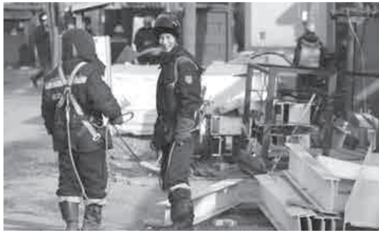
У строителей станции – хорошее настроение. Фото Ольги Кузьмичевой
