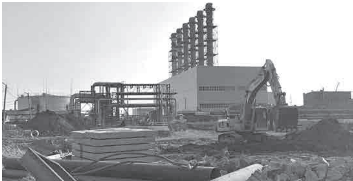
Силуэт новой ТЭЦ на фоне стройки. Фото Екатерины Подпенко
